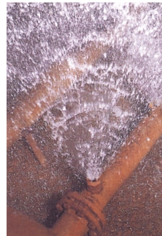
Vom Roh- zum Trinkwasser: Verdüsen als Bestandteil der Wasseraufbereitung
