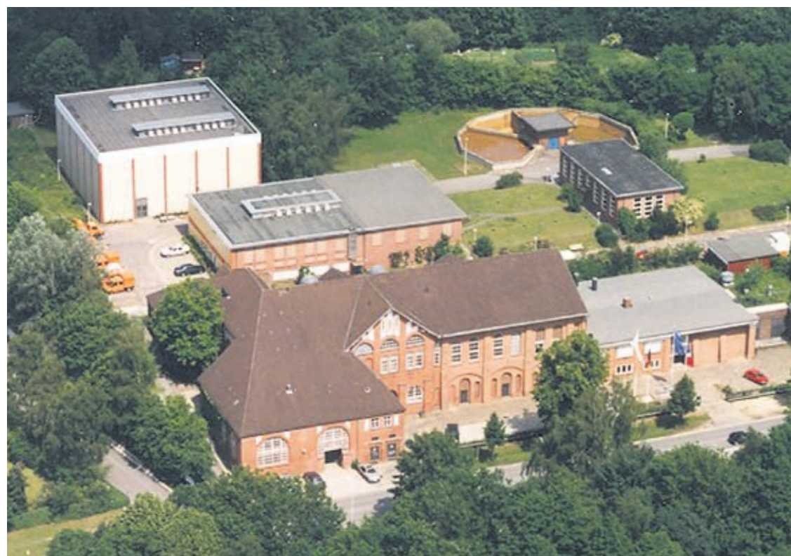
Das Wasserwerk in Schulensee: Allein von hier fließen jeden Tag 33.000 Kubikmeter Trinkwasser zu den einzelnen Hausbalten.
