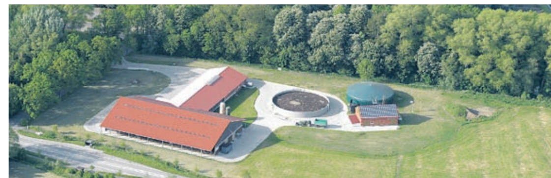
In der Biogasanlage Futterkamp dient Methan als Betriebsenergie für das Blockheizkraftwerk.
