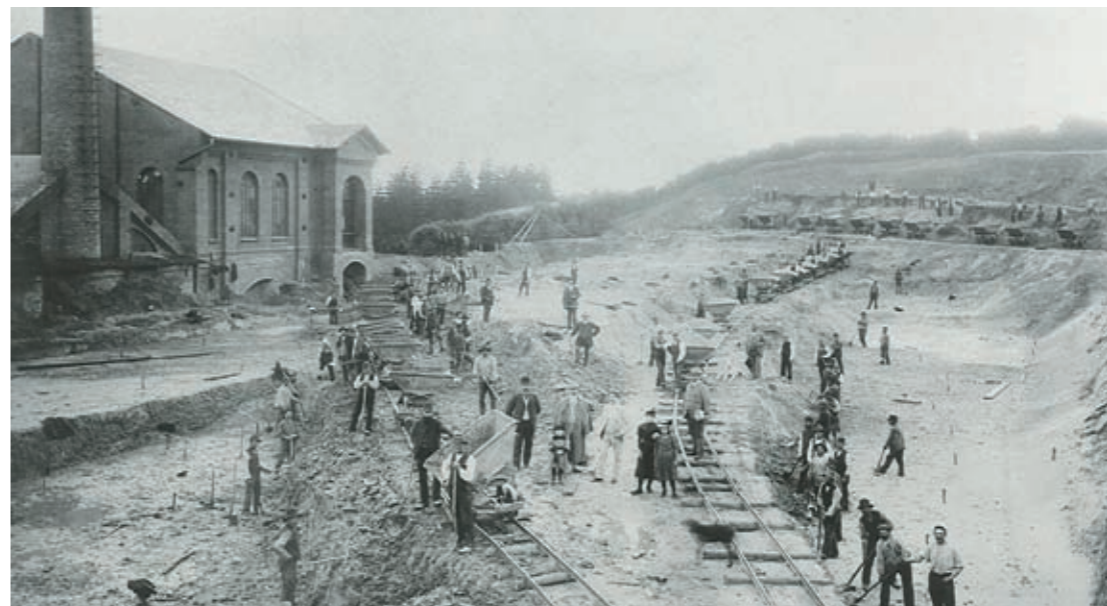
Großbaustelle: Nach aufwändigen Arbeiten ging das Wasserwerk Schulensee 1889 ans Netz.
