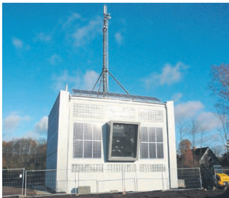
Das neue Blockheizkraftwerk Projensdorf versorgt das Neubaugebiet umweltschonend mit Energie.
