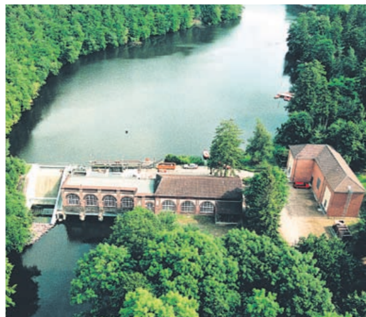
Das Wasserkraftwerk am Rosensee produziert umweltschonend Strom, der in das Netz der Stadtwerke eingespeist wird.
