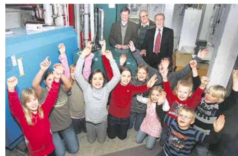
Einweihung: Die Mielkendorfer Schüler freuen sich über ihr neues Mini-Blockheizkraftwerk.
