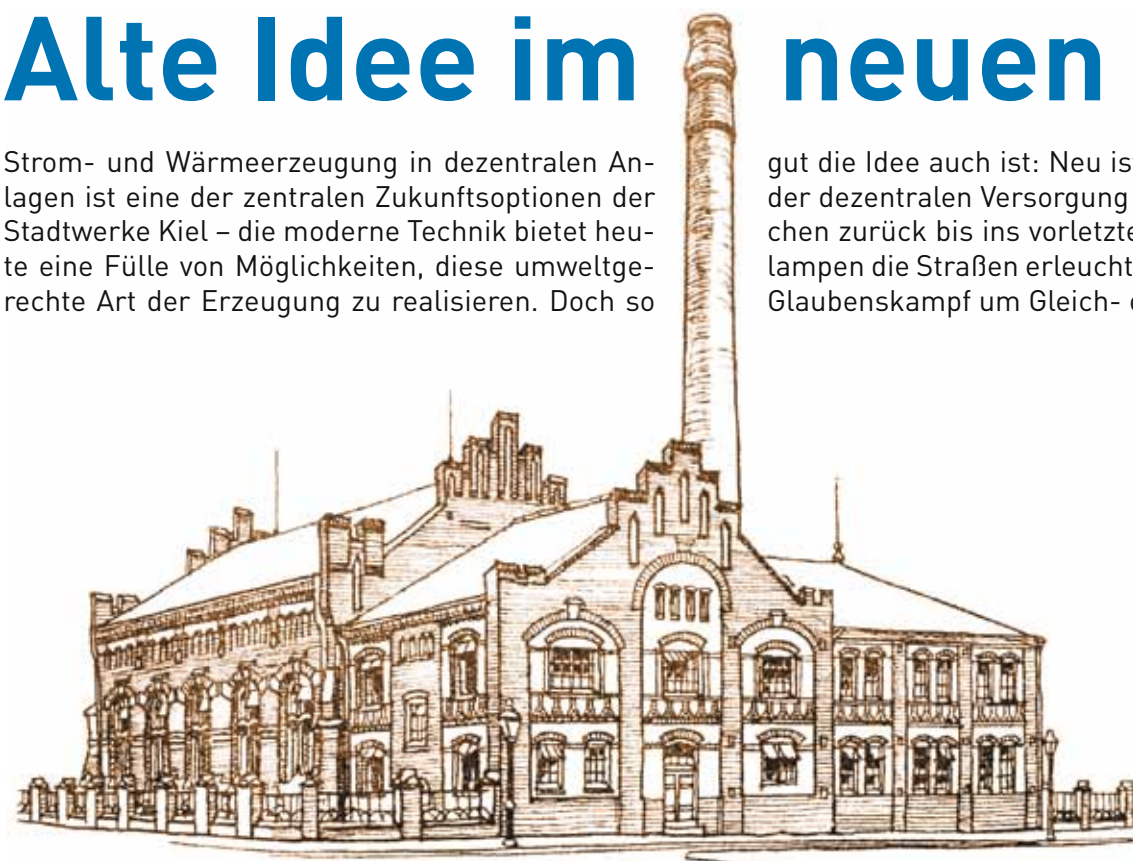
Das erste Kraftwerk der Stadtwerke Humboldtstraße wurde 1901 im Stil der Zeit erbaut. Nur die Maschinenhalle (links) steht noch. Der alte Schornstein wurde 1922 um 15 Meter verlängert.
