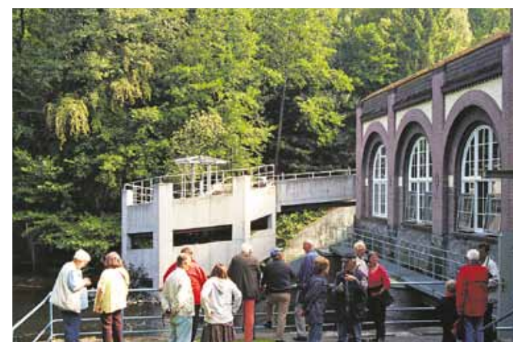
Seit langem wieder zugänglich: Das sanierte Wasserkraftwerk II in Schwentental am Rosensee.
