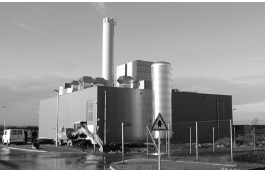
Blockheizkraftwerk Gewerbegebiet Flintbek. Dezentrale Kraft-Wärme-Kopplung, die mit Blockheizkraftwerken betrieben wird, bietet sich in Umlandgemeinden an.
